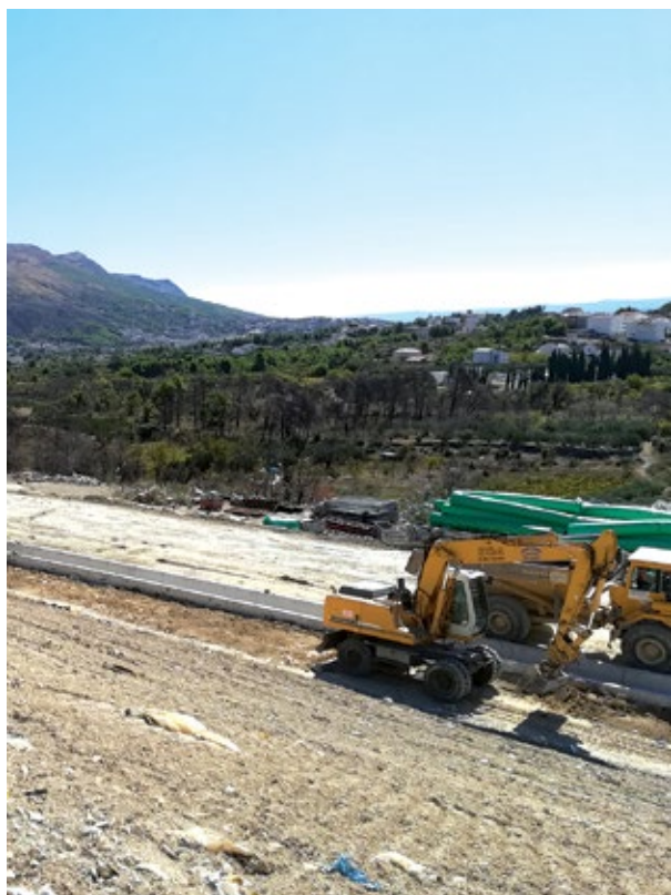
Konkretni radovi na sanaciji odlagališta Karepovac započeli su 22. studenog 2017. godine
